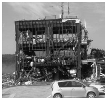
南三陸町防災センター
