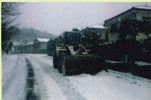
生活道路の除雪作業
