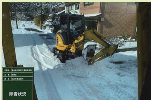
生活道路の除雪作業
